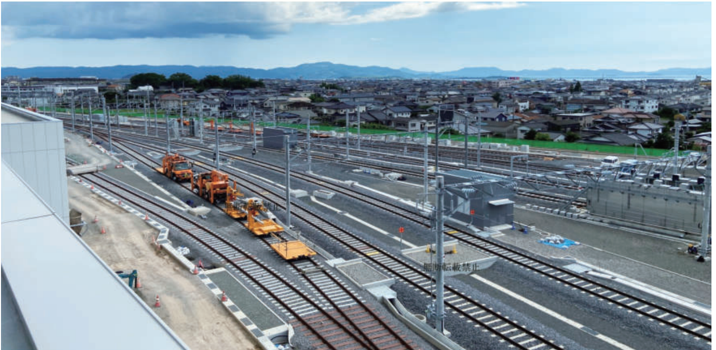
【大村市に建設中の車両基地】
